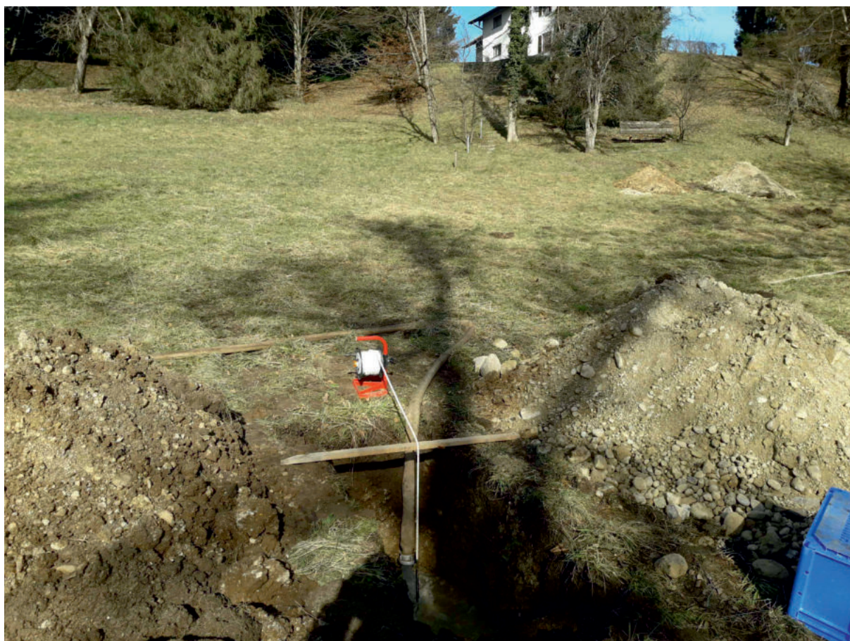
Foto 6: Befüllen des SG 3
