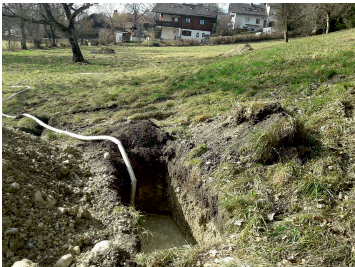
Foto 2: Befüllen des SG 1
