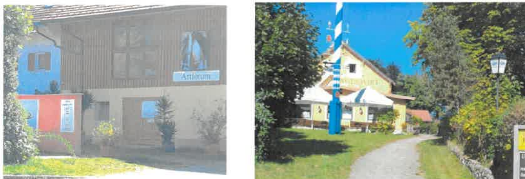
Abb. 39 links: Werbeanlagen an der Fassade sowie an einer Mauer vor dem Gebäude (Nr. 96); rechts: Fassadenmalerei am Gasthof in Nr. 98
