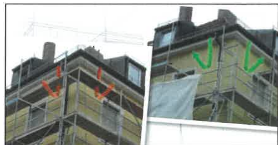
Abbildung 5: Korrekte Einrüstung an Gebäude mit Mauersegler- und/oder Sperlings- Nistplätzen. Rote Pfeile: Ausflug versperrt durch Laufbahn und Handlauf; grüne Pfeile: Geöffnetes Gerüst ohne Laufbahn und Handlauf unter den Nistplätzen (LBV 2011)
