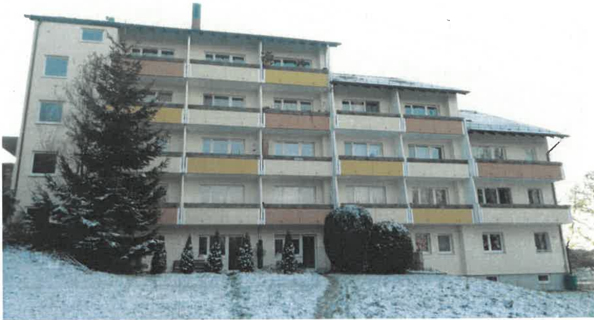
Abbildung 7: Mehrstöckiges Wohngebäude am Westrand des UG. In Spalten und Zwischenräumen im Bereich der Balkone und des Dachs sind potenzielle Einzel- und Wochenstuben-Quartiere für Fledermäuse möglich. Blick in Richtung Westen.
