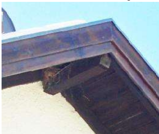
Nordseitiger Giebel des Gebäudes auf Flurstück 275/5
